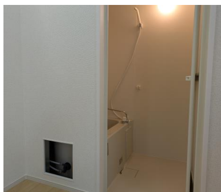
ユニットバス (壁の開口部から配管を確認できます)
