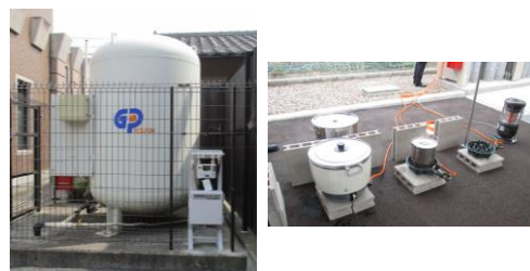
左：災害対応ユニットを設置したガスバルク 右：訓練の様子
